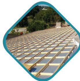
Isolants et écrans de sous toiture HPV.
